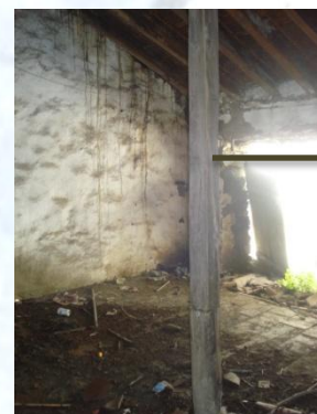
Υποστύλωμα στο δίχωρο του ορόφου
