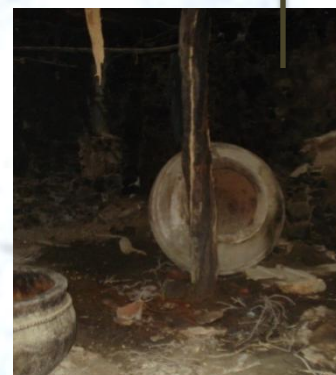
Υποστύλωμα στο δίχωρο του ισόγειου
