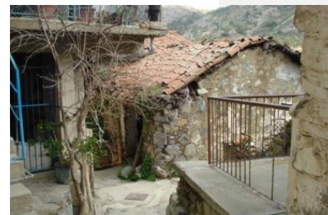
Εικόνες 24: Κυρτή ένωση τοίχων - Ευκολία πρόσβασης φορτωμένων γαϊδουριών σε στενούς δρόμους και σεισμική προστασία
